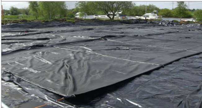
Disidratazione fanghi mediante geotessili tubolari
