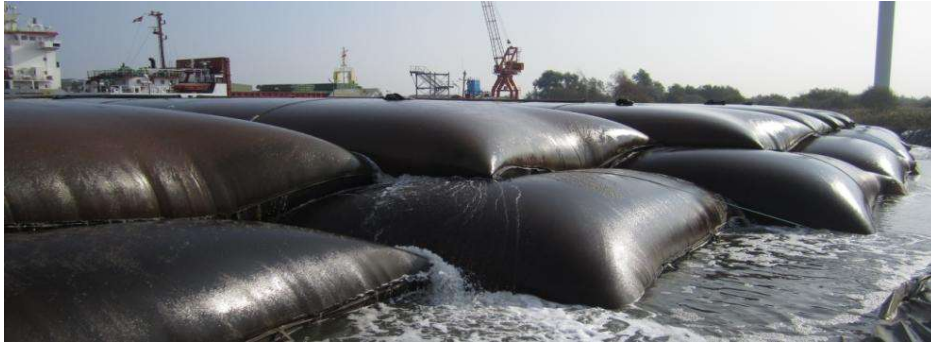
Disidratazione fanghi mediante geotessili tubolari
