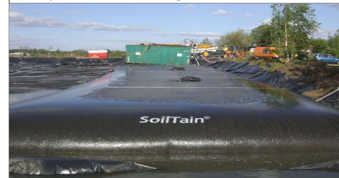
Disidratazione fanghi mediante geotessili tubolari
