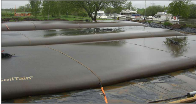
Disidratazione fanghi mediante geotessili tubolari
