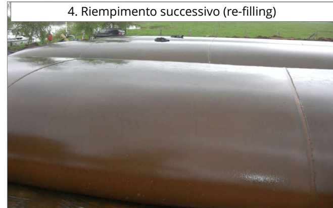
Disidratazione fanghi mediante geotessili tubolari
