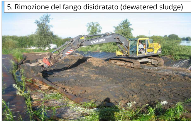
Disidratazione fanghi mediante geotessili tubolari
